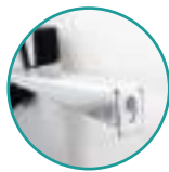
Fissaggio della struttura al muro
